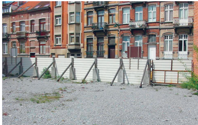
Bouwterrein parking Zonneliëd
